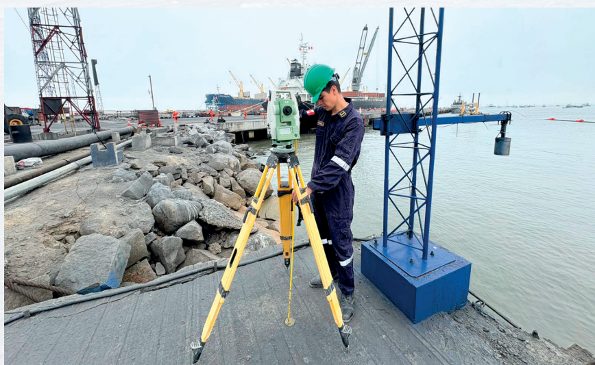
Figura 1. Instalación de la Estación Total sobre el Bench Mark.
