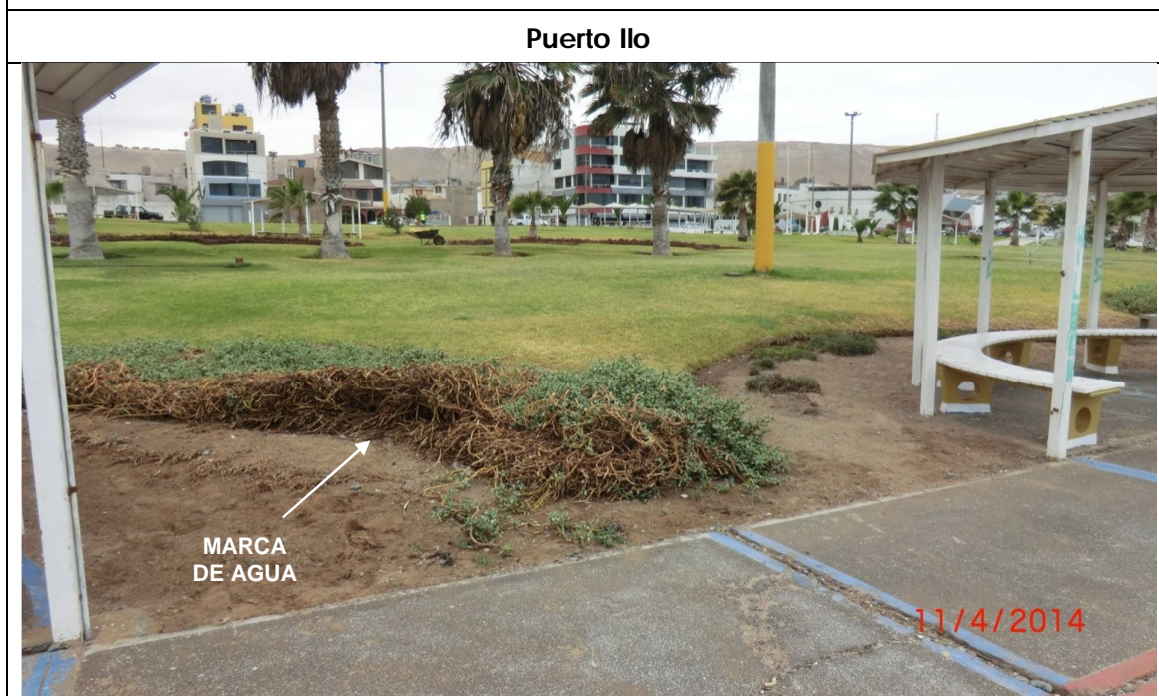
15. (Sección playa 1C- 2C) Vista del malecón frente a la municipalidad de Ilo, véase la marca de agua dejada en la zona de las pérgola, siendo una marca típica la vegetación costera, arrancadas de raíz por la inundación del tsunami.
