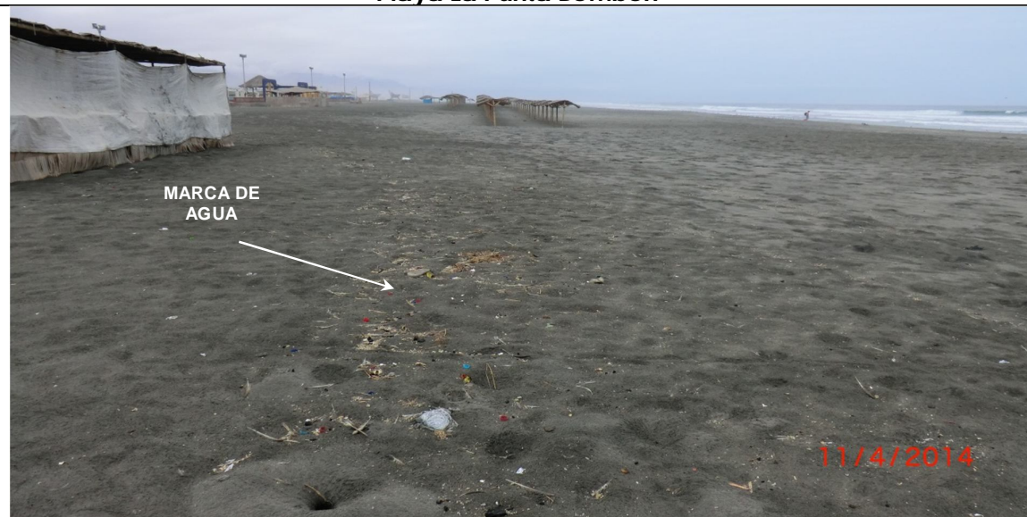
6. En Punta Bombón se pudo observar las huellas dejadas por la ola de tsunami con la Permanencia de sedimentos y desperdicios hacia la orilla.
