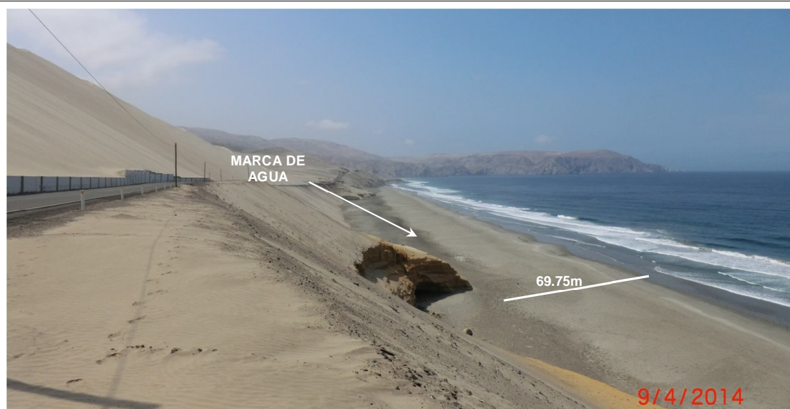
2. Vista panorámica de playa Muerta, obsérvese la zona de inundación con una extensión promedio de 69.75 m
