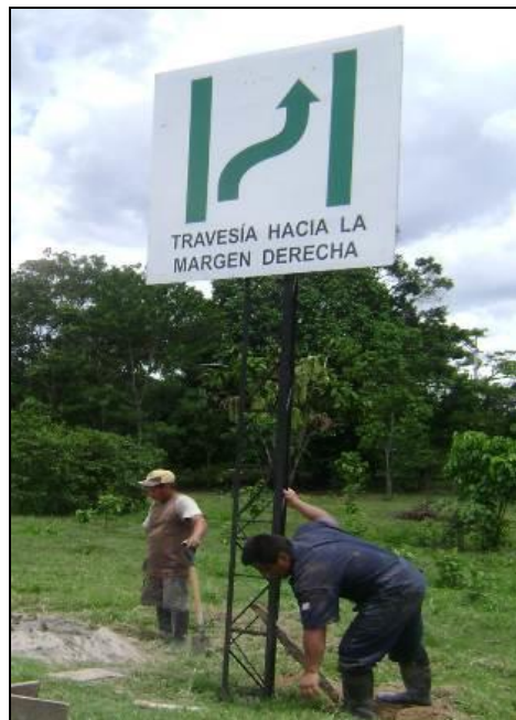
Letrero señalizador de canal río Huallaga
