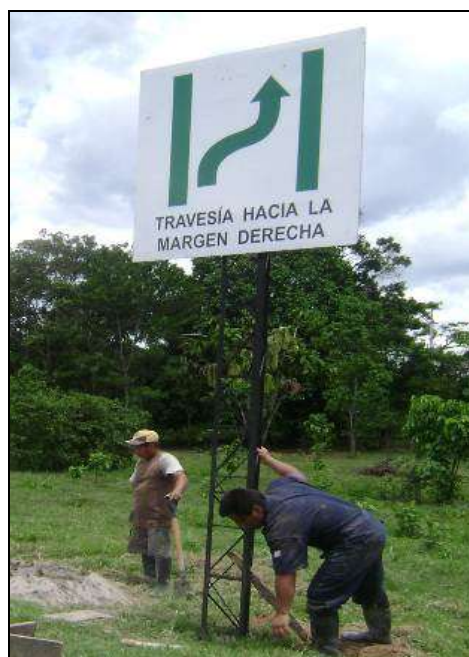
Letrero señalizador de canal río Huallaga
